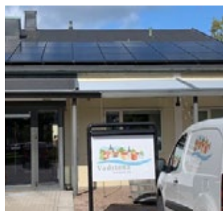
Solceller monterade på kontorstaket
